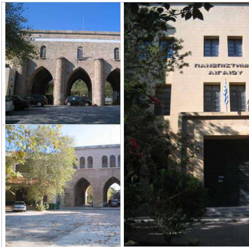
Εικ. 2. Όψεις της πρώην Σχολής Χωροφυλακής η οποία επισκευάστηκε και ανακαινίσθηκε προκειμένου να στεγαστεί το Π.Τ.Δ.Ε. του Πανεπιστημίου Αιγαίου στη Ρόδο. Σήμερα, στα κτήρια αυτά στεγάζονται επίσης, το Τ.Ε.Π.Α.Ε.Σ. και το Τ.Μ.Σ..
